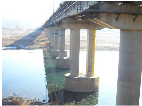
교각 P11~P16 전경
