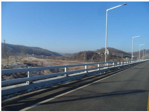
난간 및 연석 전경
