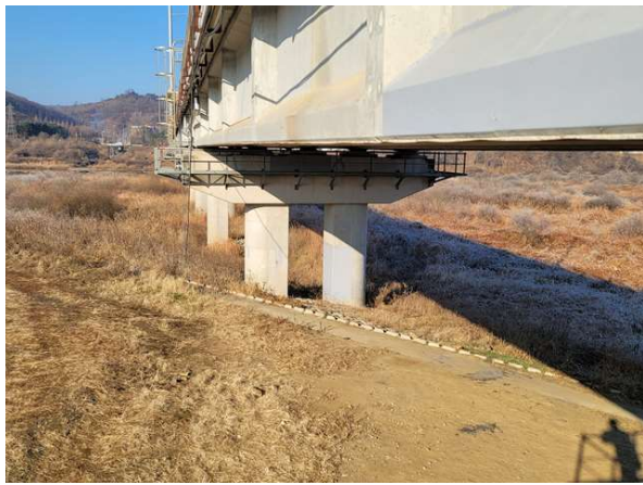
교각 P2~P10 전경
