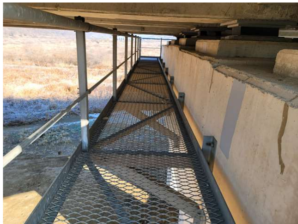
교량 점검시설 전경
