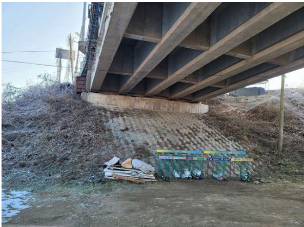
교대 A1 전경
