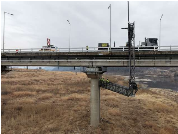
굴절점검차를 이용한 현장조사
