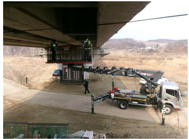
고소점검차를 이용한 현장조사
